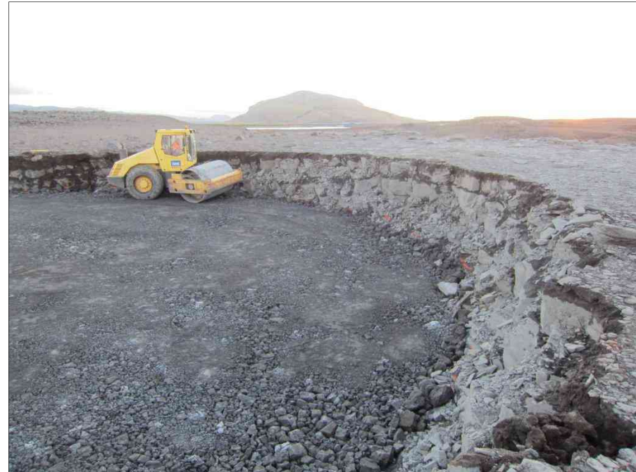
Mynd 3.3 Jarðvegsskipti og þjöppun lands fyrir undirstöður.
