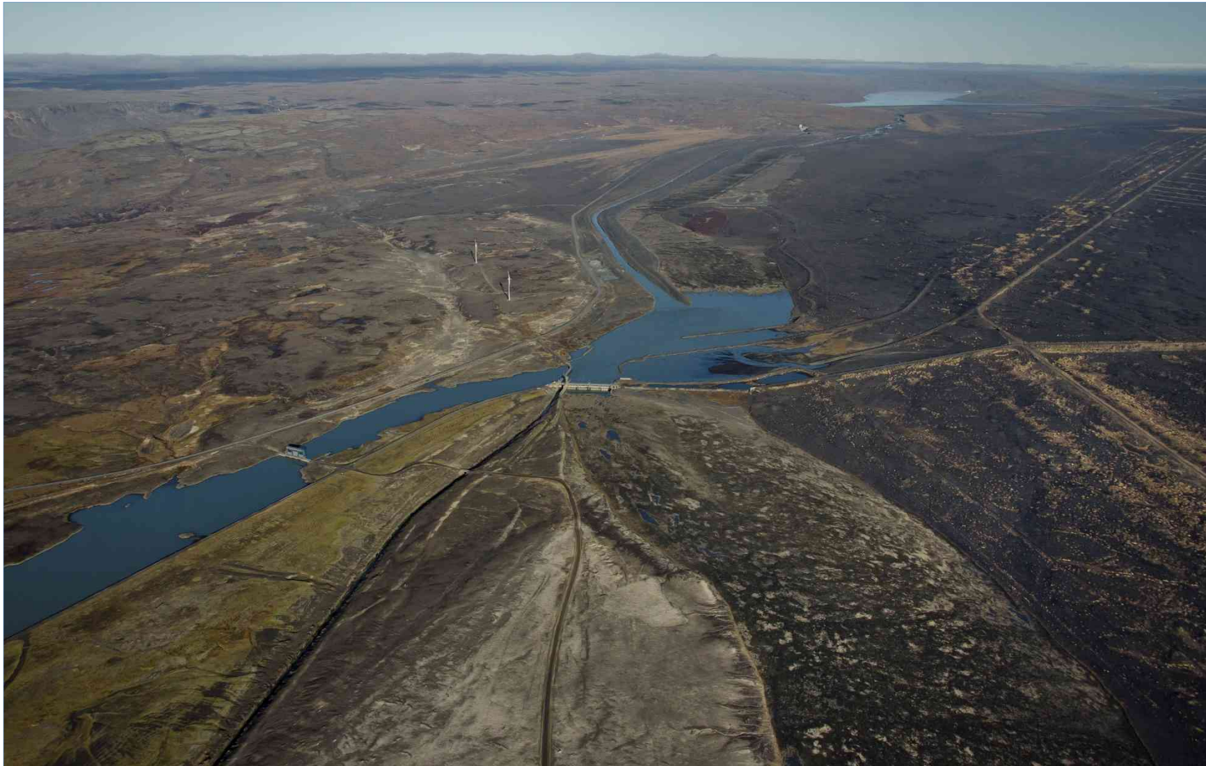
Mynd 2.1 Horft yfir fyrirhugaðan Búrfellslund til norðausturs. Fyrir miðri mynd eru rannsóknarvindmyllurnar, Bjarnalón, frárennisskurður Sultartangavirkjunar og Ísakot. Sultartangalón er efst á myndinni. (Mynd: Emil Þór)
